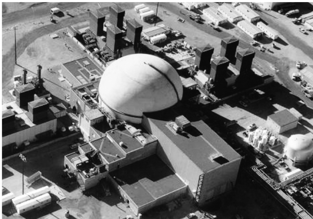
Рис.4: Испытательная установка с большим потоком в Хэнфорде (Вашингтон). Фото Федерации американских ученых.
