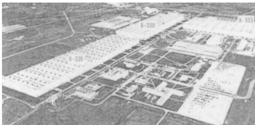
Рис.4а: ГДЗ в Портсмуте (США), видны производственные здания X-326, X-330 и X-333. Обратите внимание на установленные на крыше вентиляторы для рассеивания горячего воздуха.
