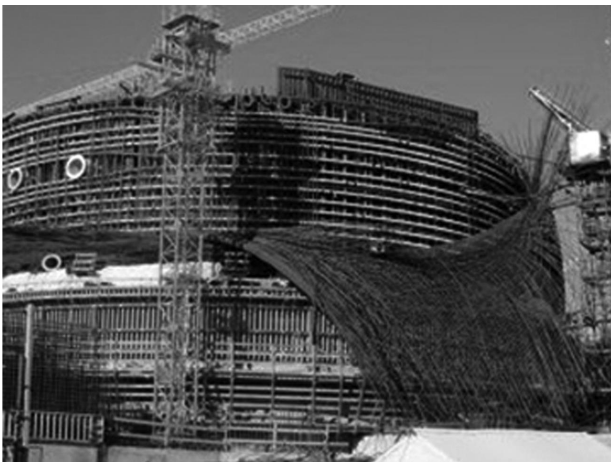
Рисунок 1. Сложившаяся арматурная сетка в строящемся корпусе блока № 1 Ленинградской АЭС-2.
